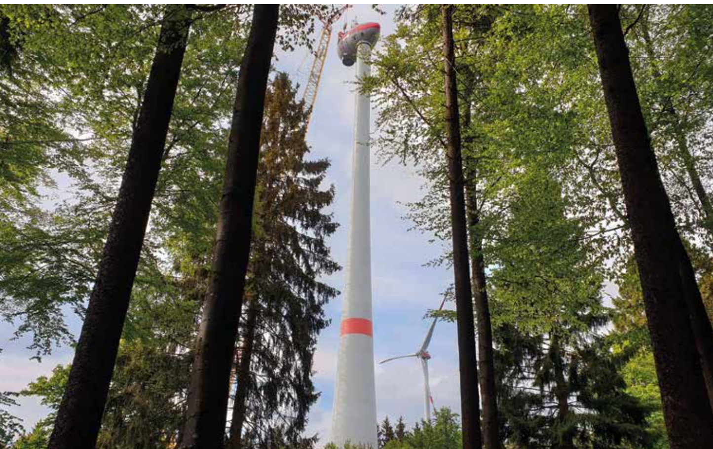
Standort WEA 8 – Die Gemeinde Dahlem gab auf Empfehlung des Umweltministeriums NRW das Gemeindegebiet vollständig zur Errichtung der WEA frei
