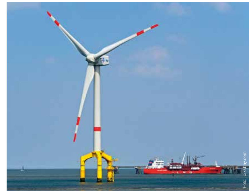
Die Fundamente von Offshore-Windkraftanlagen werden mit vielen Hundert Schlägen in den Meeresgrund gerammt
