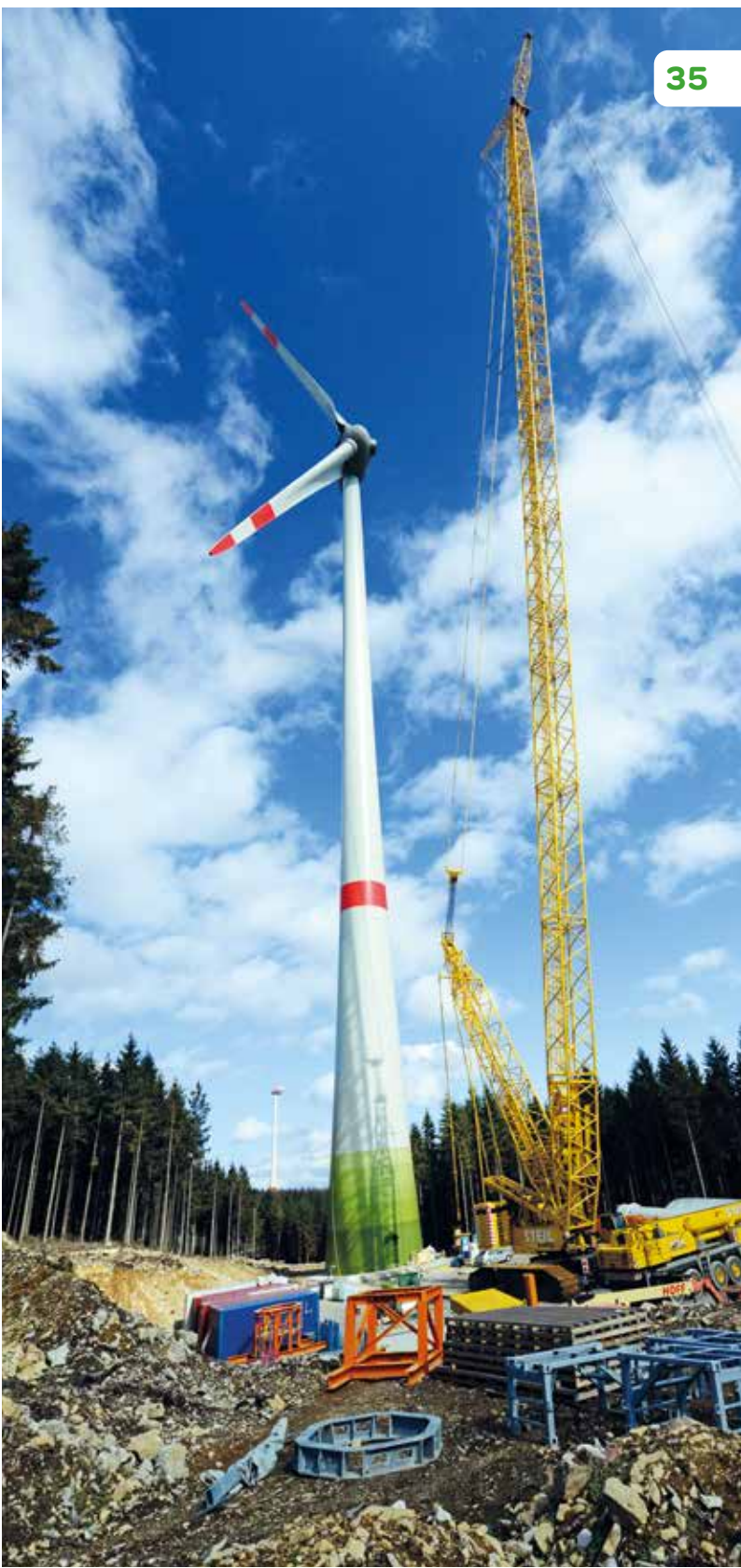
Die Windkraftlobby arbeitet an einer gesellschaftlichen Spaltung
