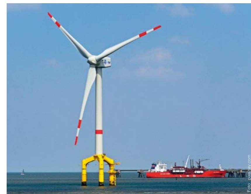
Die Fundamente von Offshore-Windkraftanlagen werden mit vielen Hunderten Schlägen in den Meeresgrund gerammt
