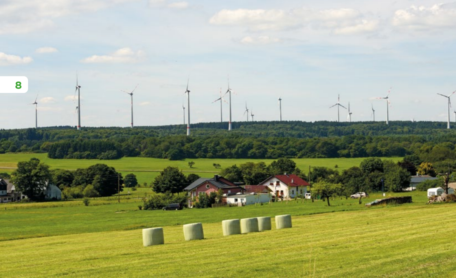
Windräder im Wald sind der vermutlich letzte Akt der systemischen Zerstörung unserer Wälder
