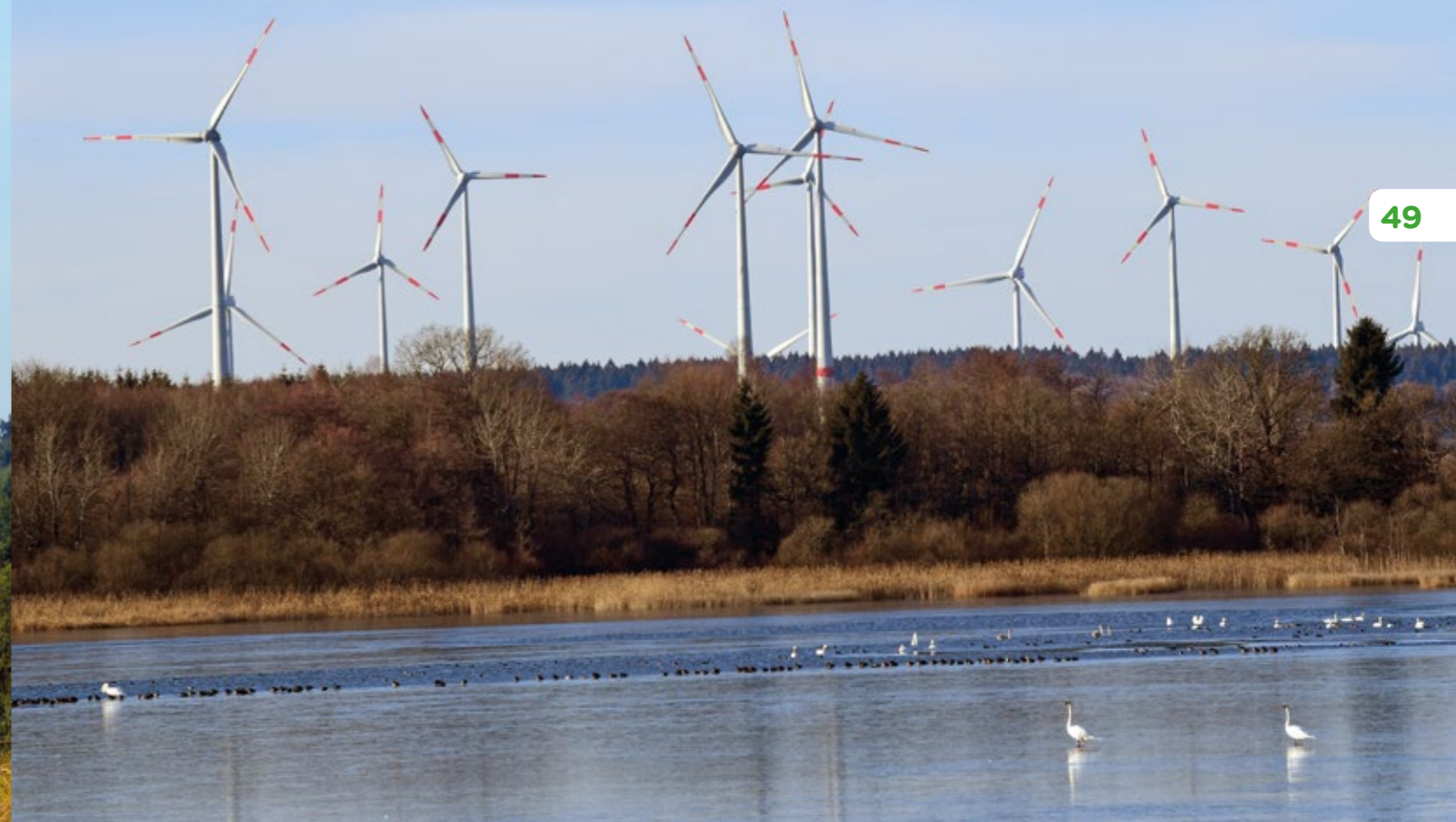
Windenergieanlagen im Wald in und an einem FFH- und Vogelschutzgebiet im nördlichen Rheinland-Pfalz
