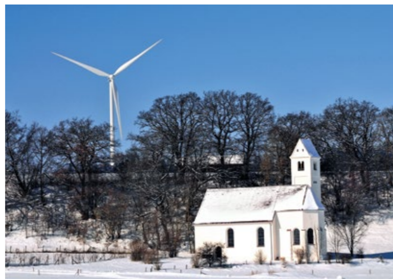
Zerstörung eines exponierten Standortes
