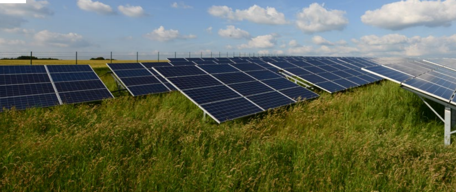
Kein weiterer Flächenverbrauch: Photovoltaik gehört auf's Dach, nicht auf's Land!
