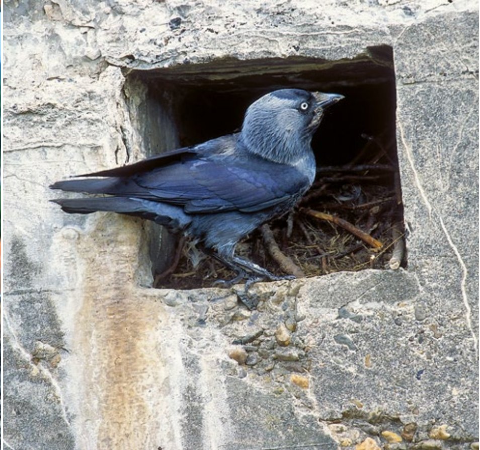
Dohle ( Corvus monedula ), Maueröffnung im Turm als Brutplatz - Foto: Robert Groß
