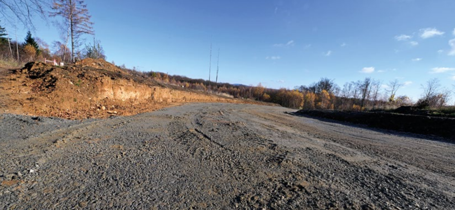
Industrielle Zerstörung eines gesamten Höhenrückens auf ca. 2,5 km Länge durch Windindustrieanlagen mit bis zu elf Meter breiten Waldautobahnen, Bodenabtragungen und Einschnitten von bis zu sechs Meter Höhe in einem Wasserschutzgebiet (Haiderbachhöhe/Ransbach-Baumbach/Westerwald). Hierzu auf dem YouTube-Kanal des Verfassers ein Film: https://www.youtube.com/watch?v=Ca5H2FYQdY
