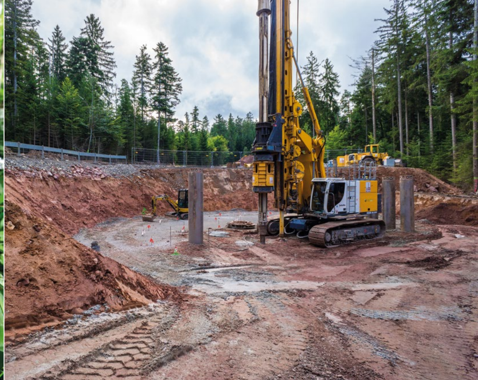
Gewaltige Beton-Fundamente, rund 15 m tief, müssen für diese Anlagen in die Erde getrieben werden - Foto: Joachim Wasserthal
