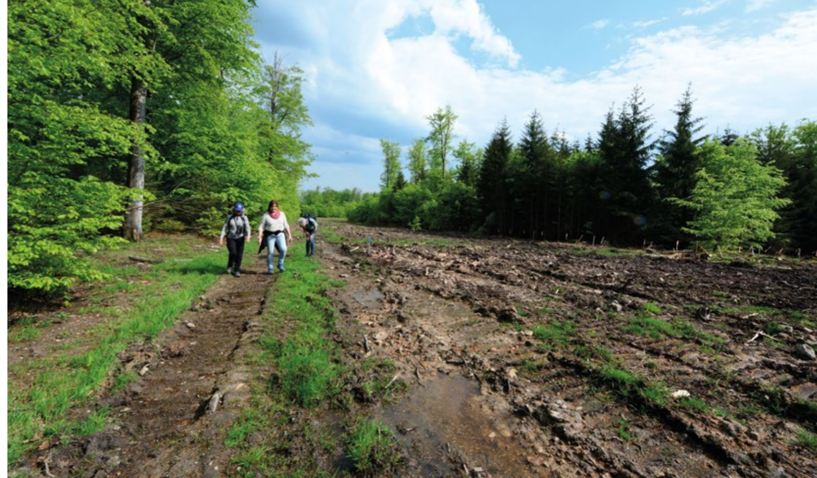
Abb. 3: Autobahnähnlicher Straßenbau auf einer Länge von fast fünf Kilometern in Deutschlands Märchenwald, Reinhardswald
