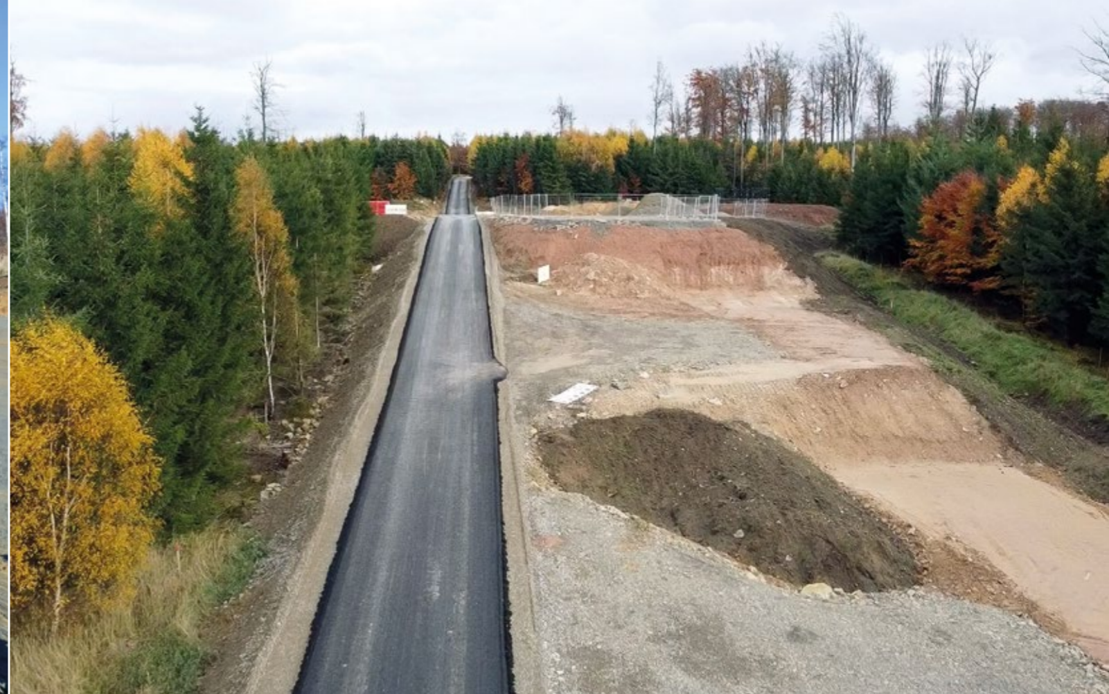
Abb. 2: Bauarbeiten für WKA-Zuwegungen im Reinhardswald, Hessen (Quelle: Oliver Penner, www.rettet-den-reinhardswald.de)
